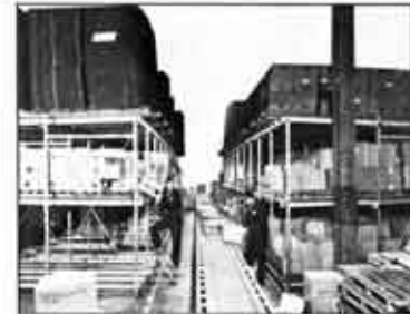
Impianto «PALLETFLO» per prelievi ordini, su due piani, per una catena di ristoranti. Sul terzo piano vengono sistemati i pallets con gli imballi.
